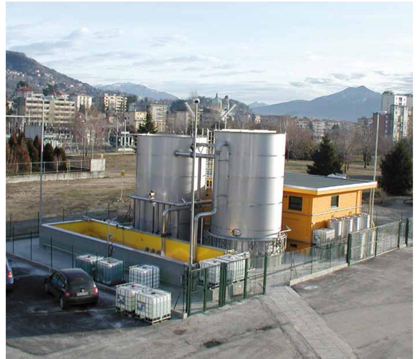
action mécanique de rétention des MES\* par filtration et d'une transformation biologique de polluants contenus dans les eaux à traiter par intervention de microorganismes.
